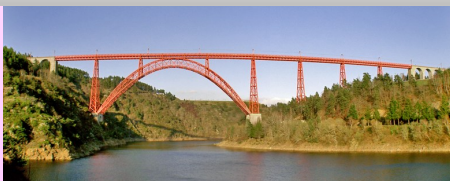
Viaduc de Garabit
