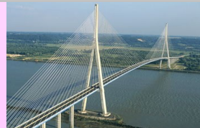
Pont de Normandie
